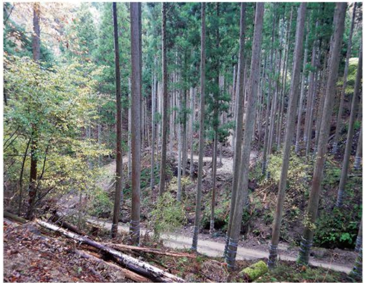
新設した林内作業道
