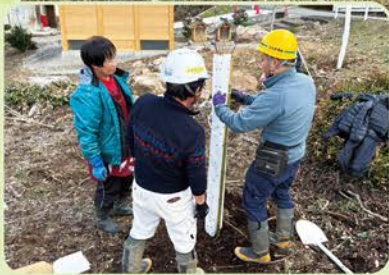
◀ 獣害防止の資材 (ハイトシェルター)を 施工
